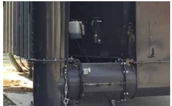
Trogsschnecke mit Stopfknoten: Verhindert Brückenbildung durch direkte Materialübergabe in die Windungen der Hochförderschnecke.
