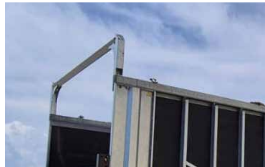
Streben zur Stabilisierung der Wände
