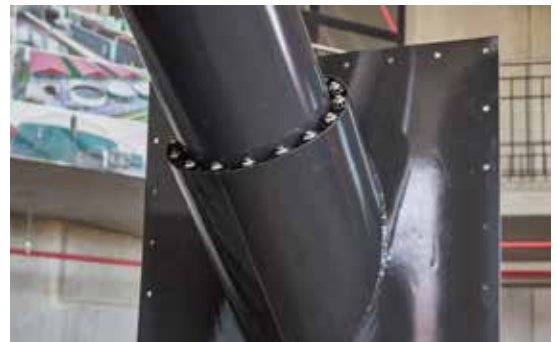
Rohr-in-Rohr-Anschluss mit Gliederringdichtung: Ermöglicht eine schweißfreie Montage sowie den einfachen, wartungsfreundlichen Austausch des Einbringrohrs im Fermenter.
