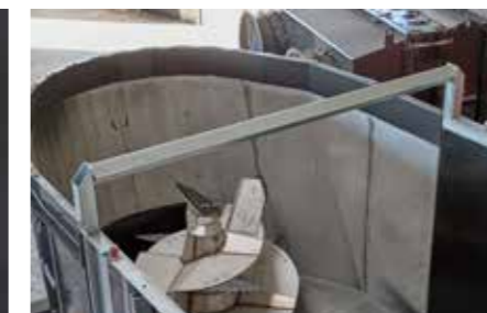
Streben zur Stabilisierung der Wände
