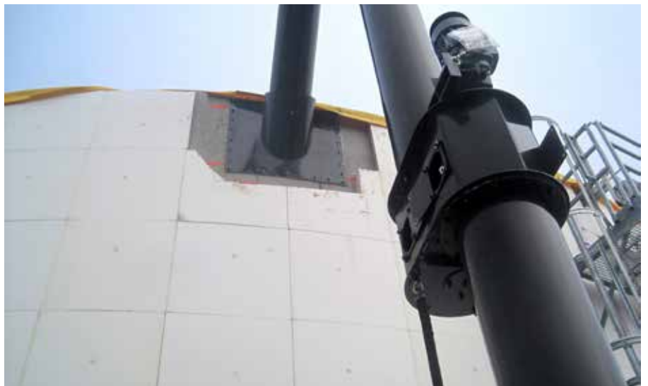
Vis de convoyage (gaine) de plus de 7000 mm de long avec nœud de transmission.
